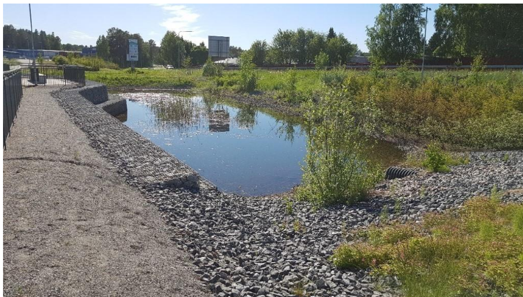
Figur 17. Dagvattendamm i Luleå (foto: AFRY).
