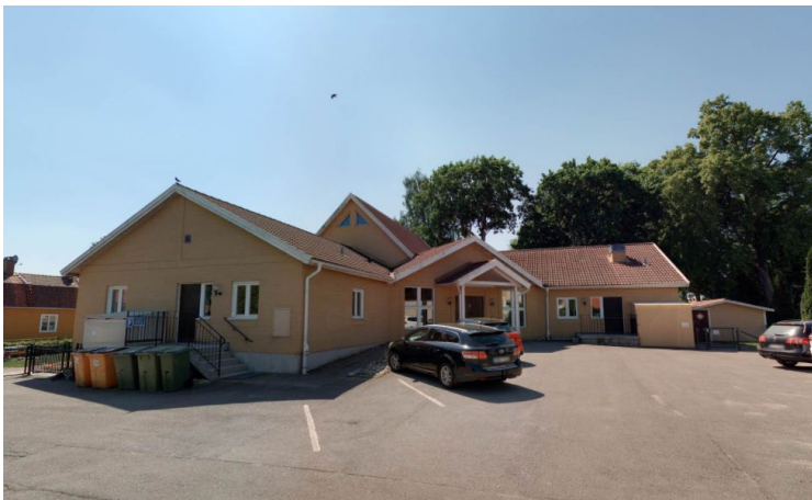
Samlingslokal och tidigare frikyrka inom fastigheten Vilan 3
