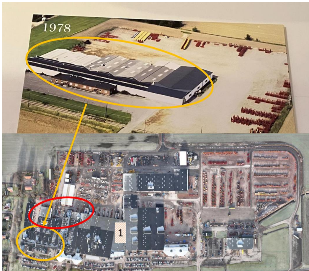
Figur 5 Bild ovan visar bolagets utbredning 1978 och dess lokalisering på flygfotot vid dagens verksamhet, dvs de äldsta delarna av verksamheten är i de västra delarna av fastigheten. Röd ring visar enligt uppgift det området där kemikalier och avfall i huvudsak har hanterats. Det rasterade området markerat med 1 är den plats där den tidigare deponin var placerad.
