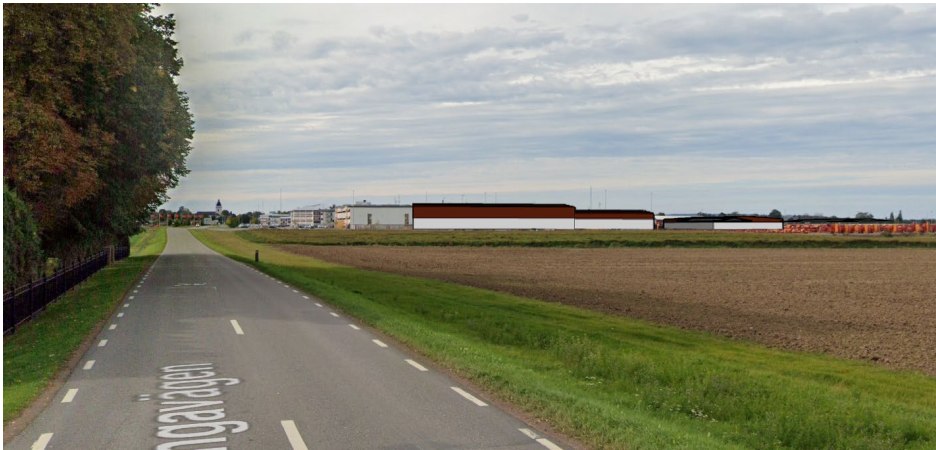
Vy från Hogstadvägen, sydost om befintlig anläggning.
