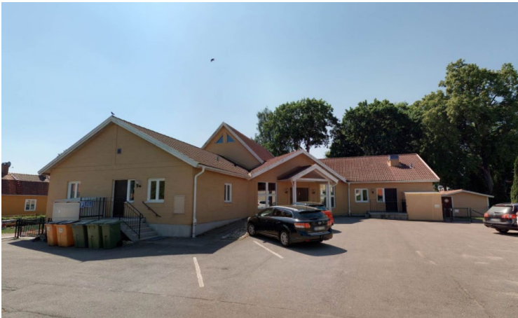
Samlingslokal och tidigare frikyrka inom fastigheten Vilan 3
